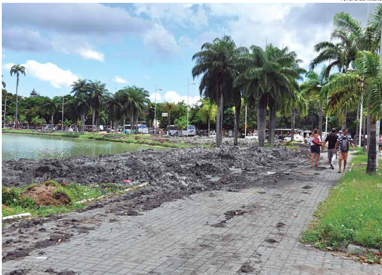
Devido as obras de infraestrutura do Parque Solon de Lucena, o trânsito está com alterações para a retirada de areia e detritos
